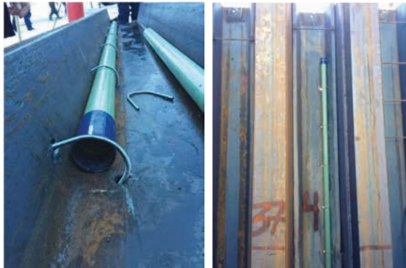
Рис. 3. Положение трубы на шпунтине
