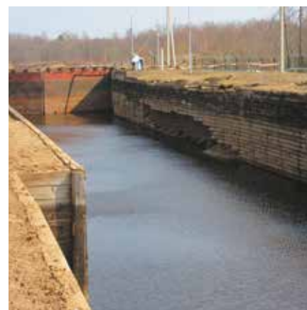
Рис. 2. Шлюз № 5 до реконструкции
