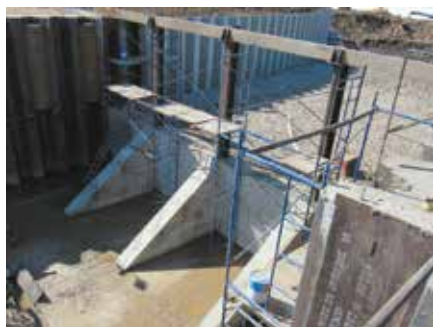
Рис. 3. Реконструкция верхней головы шлюза
