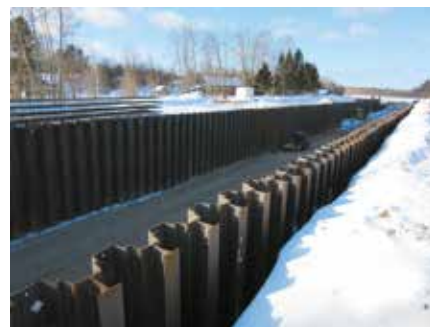
Рис. 4. Реконструкция камеры шлюза
