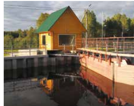
Рис. 7. Электромеханический привод двустворчатых ворот шлюза № 5
