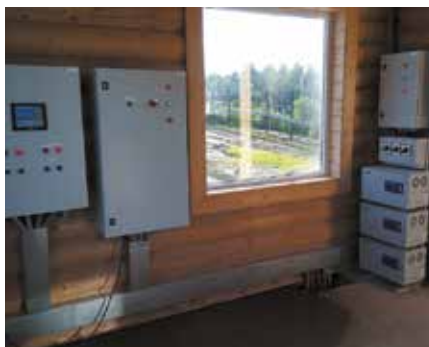
Рис. 6. Часть АСУ в пункте управления шлюзом
