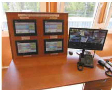
Рис. 5. Пульт управления шлюза № 5 в диспетчерской
