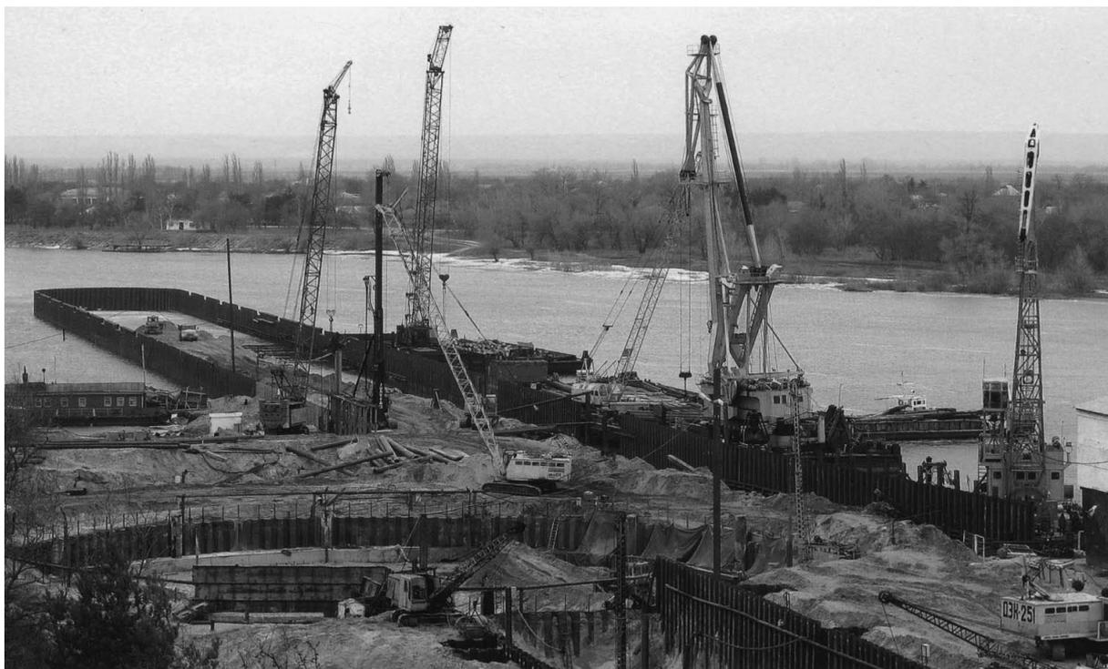
Рис. 5. Общий вид камеры шлюза, нижней головы и причальной стенки
