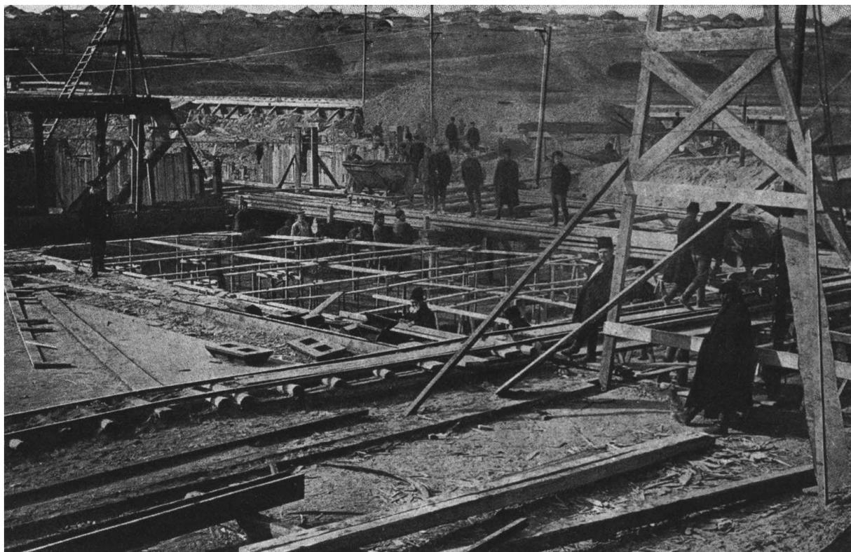
Рис. 3. Работы по бетонированию верхней головы шлюза гидроузла № 6
